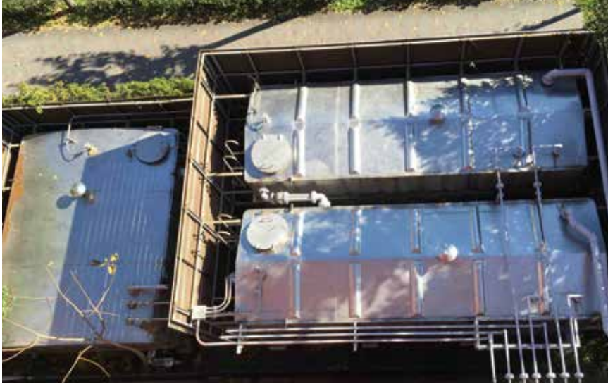
廃止した廃棄施設の排水設備 (RI貯留槽)
